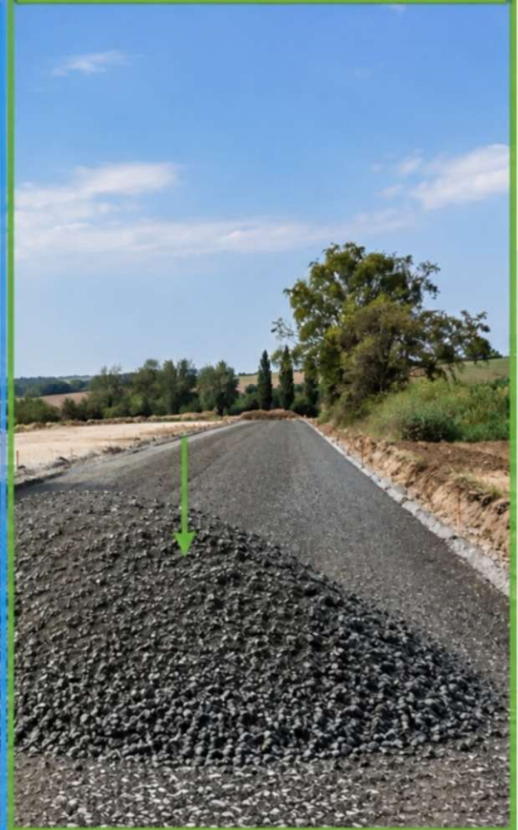
3. CUMULO PER FONDO STRADALE
